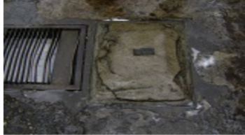
Foto No. 1: Vista General de la Placa de concreto del Sellamiento temporal.
